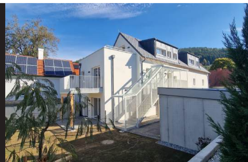
DAHEIM IN PASSAIL | UMFASSENDE SANIERUNG
