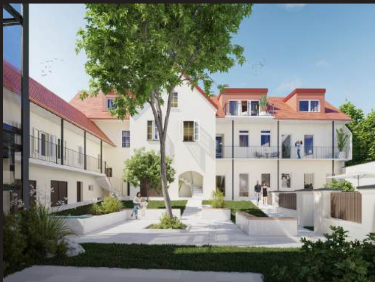
DAHEIM IN FROHNLEITEN | UMFASSENDE SANIERUNG
